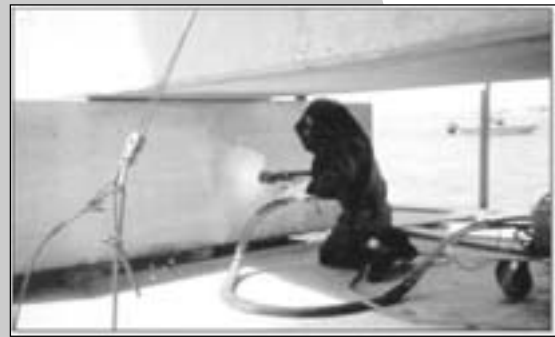
شکل ۵- پاشش حرارتی آلیاژی Al-Zn-In بر روی پایه پل.
