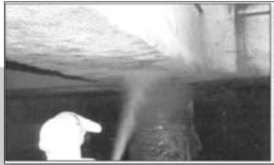
شکل ۴- روکش دهی شبکه آند تیتانیومی.
