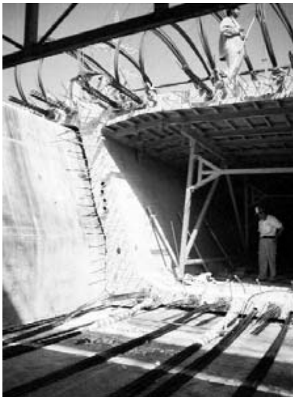
شکل (۲) - ساخت هر قطعه تابلیه و نصب به کمک عملیات پیش‌رانی
