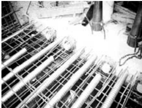
شکل (۴) - تعبیه غلاف‌های پس تیدگی در محل‌های معین
