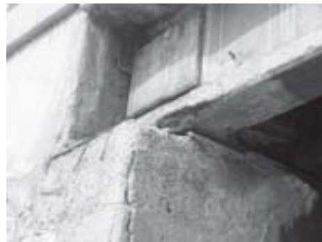
شکل ۱۱- نمونه هایی از سطح خرابی C۳ در شاهتیرها و کوله و سرستون های بتنی پل کلاک
