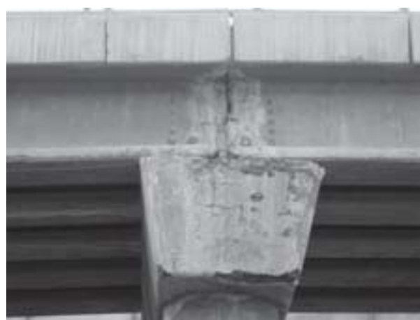
شکل ۱۰- نمونه هایی از سطح خرابی C۲ در شاهتیرها و سرستون های بتنی پل کلاک
