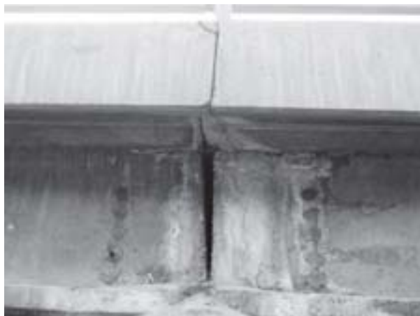
شکل ۹- نمونه هایی از سطح خرابی C۱ در شاهتیرهای T شکل بتنی پل کلاک
