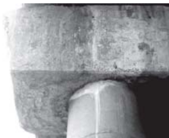
شکل ۱۰- نمونه هایی از سطح خرابی C۲ در شاهتیرها و سرستون های بتنی پل کلاک
