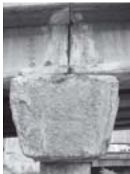
شکل ۱۱- نمونه هایی از سطح خرابی C۳ در شاهتیرها و کوله و سرستون های بتنی پل کلاک
