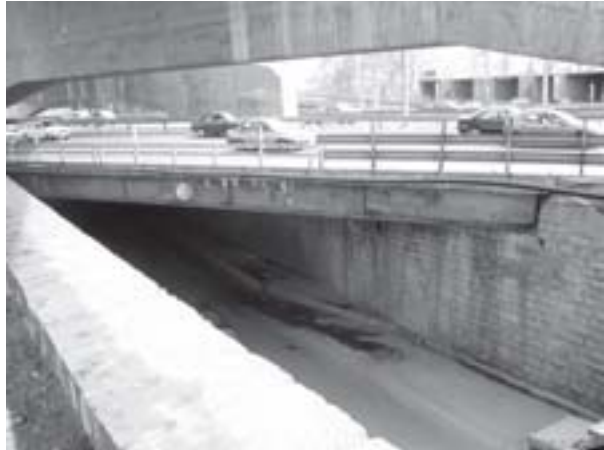
شکل ۶- نمایشی از ورودی پل زیرگذر از سمت کرج
