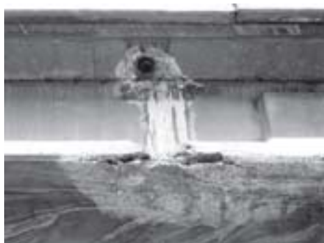
شکل ۱۱- نمونه هایی از سطح خرابی C۳ در شاهتیرها و کوله و سرستون های بتنی پل کلاک
