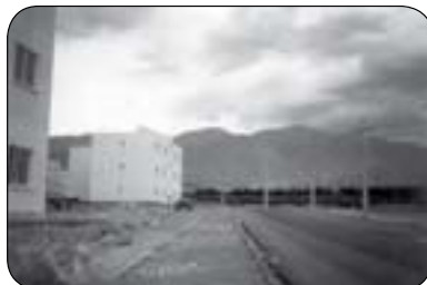
خانه سازی زلزله زدگان منجیل
